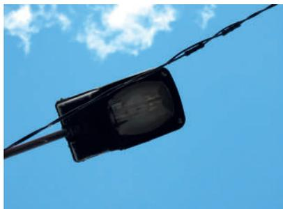
À ce jour, il a permis de remplacer 314 luminaires vétustes équipés dorénavant de sources LED, de meilleure efficacité lumineuse tout en réduisant de plus de 60% la puissance nécessaire.
