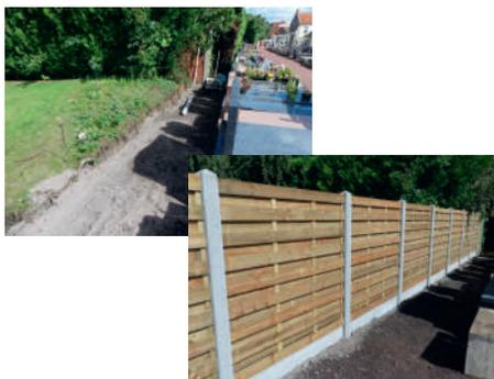
La clôture de panneaux lattes bois est à la fois ajourée, pour ne pas constituer un obstacle au passage des eaux, et occultante.
